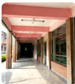
校舍1-4樓 油漆粉刷工程
