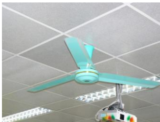
教室裝設風扇可有效利用空調
