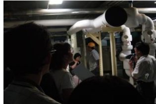
自動管制中央空調冰水主機
