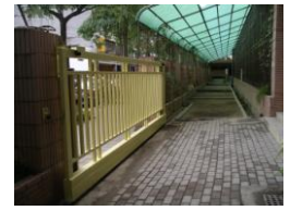
南側門施工後
