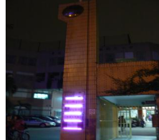
結合風力發電供夜間照明系統
