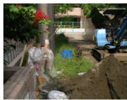
生態池施工前
