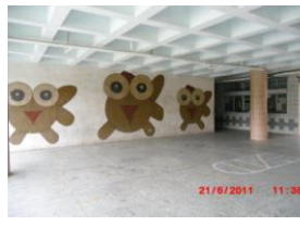
故事屋施工前
