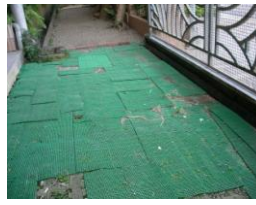
南側門施工前
