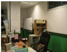
資源班施工前
